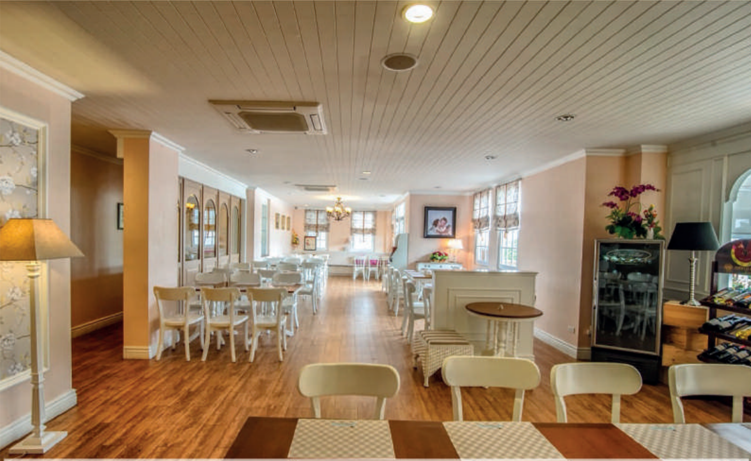
ตกแต่งภายในด้วย ไม้ระแนง เอสซีจี สีซีเมนต์ ทาด้วยสีน้ำอะคริลิกสีขาว ช่วยให้เพดานดูสวย สะอาดตา และลายเส้นที่ช่วยเสริมสร้างให้เพดานดูมีมิติมากขึ้น สถานที่ : ร้านไวไววรรณ หัวหิน จ.ประจวบคีรีขันธ์
